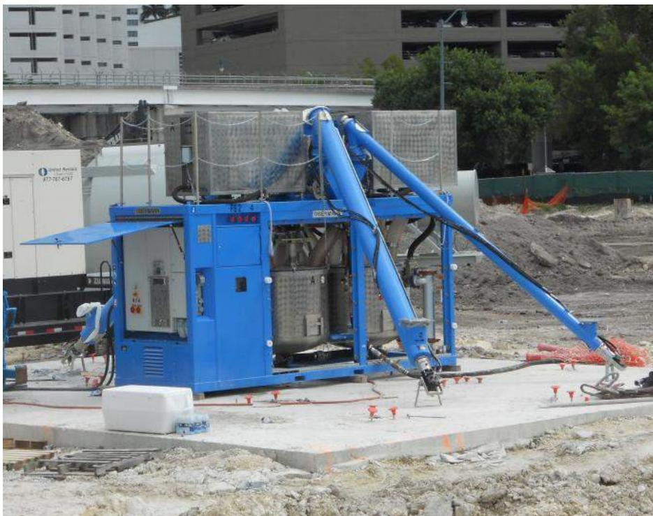
**Mischanlage OM 1000/2-48 mit hydraulisch angetriebenen Förderschnecken**
